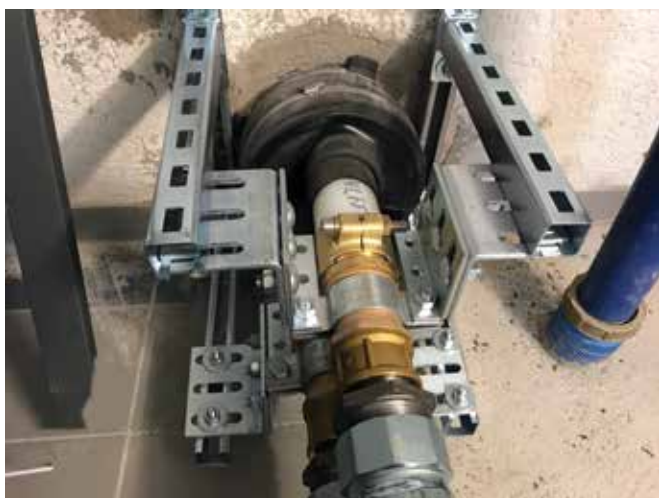
Optimal ausgeführter Fixpunkt mit Wipex-Fixpunktmuffen und Fixpunktschellen für ein Uponor Ecoflex Thermo Twin Rohr 2x75x6,8/250
